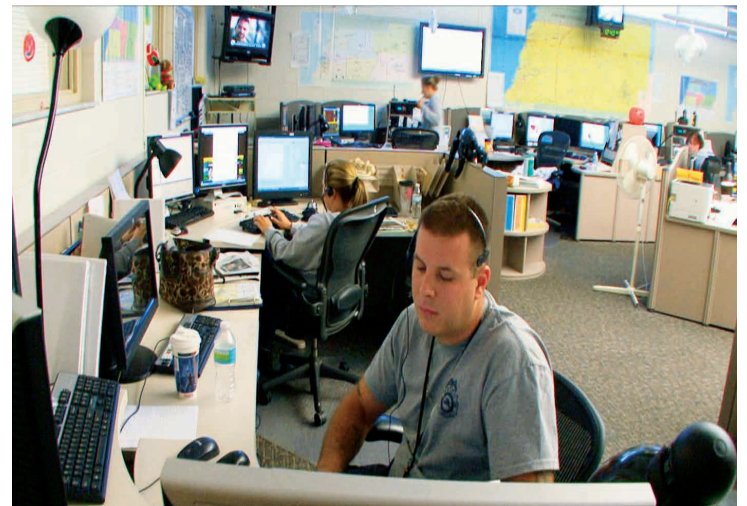
帕斯科县 (Pasco County) 建立了一个具备 SmartRow 产品的内部消防系统和降噪装置的数据中心, 让员工能够安全舒适地工作。
